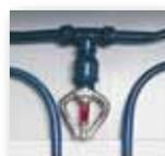
**1** Une sécurité complémentaire avec un extincteur monté sur la tuyauterie permet de libérer le liquide
