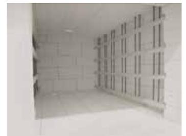
Grille protectrice devant les modules de chauffage en guise de protection contre les dégradations mécaniques
